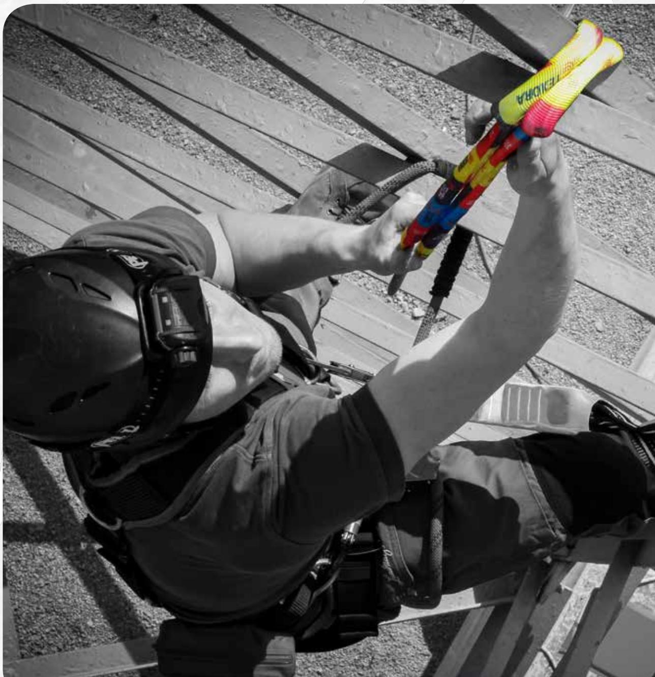
„Unsere Rainbow Sling TX/L-Compact ist nach DIN EN 354 und DIN EN 795B zertifiziert und besitzt eine enorme Bruchfestigkeit von 100kN!“
